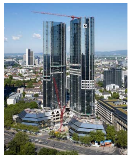
Umbau der Taunusanlage - 2009
